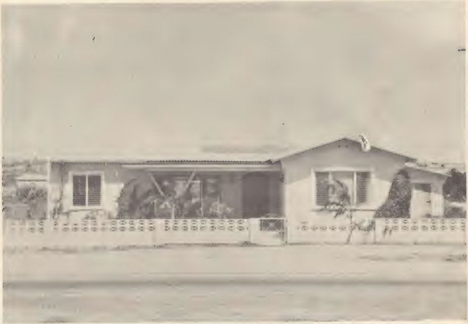
Voorgevel veel gebouwd woningtype Arch. F. Dykhoff
